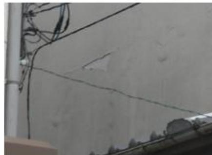
塗膜内部に水の浸入が原因で、壁が膨れたり剥がれたりしています。
